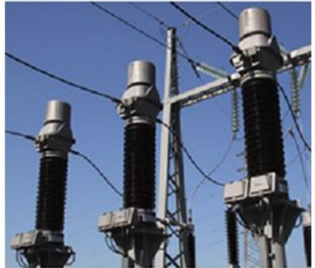
Slika 6.15: Kombinirani transformator, tip Končar VAU
