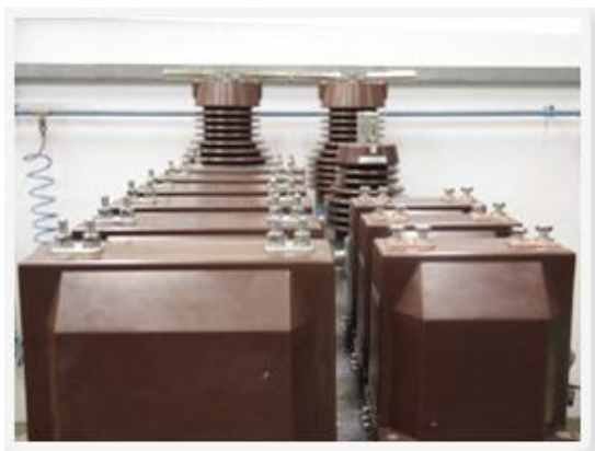
Slika 6.6: ST tipa INA (za unutarnju montažu)
