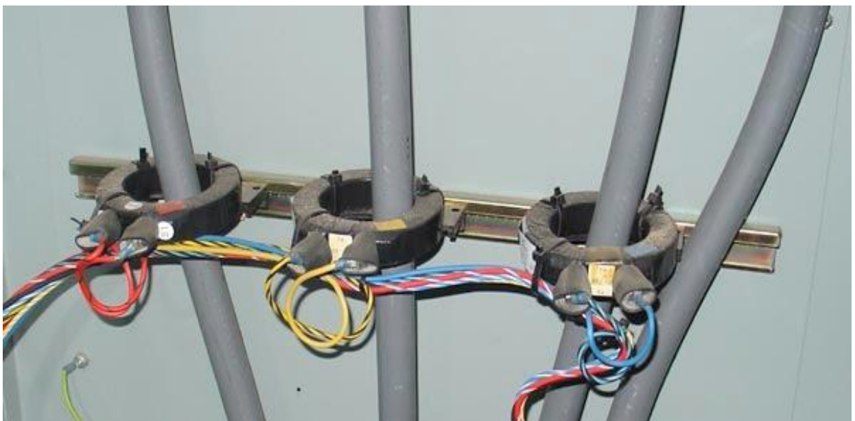
Slika 2.1: Primjer jednostavne izvedbe NN provlačnog SMT-a
