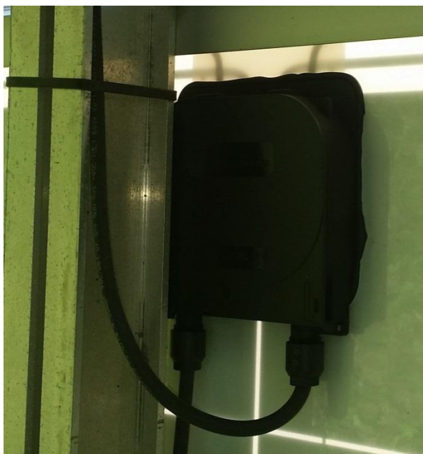
Slika 3.6. Priključna kutija fotonaponskih modula
