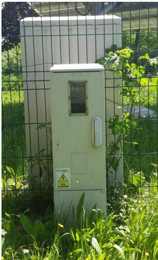
Slika 4.11. Obračunsko mjerno mjesto s brojilom
