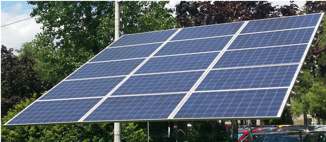
Slika 4.6. 15 panela spojenih u seriju
