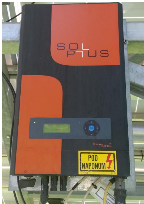
Slika 4.7. Izmjenjivač Solplus SP50
