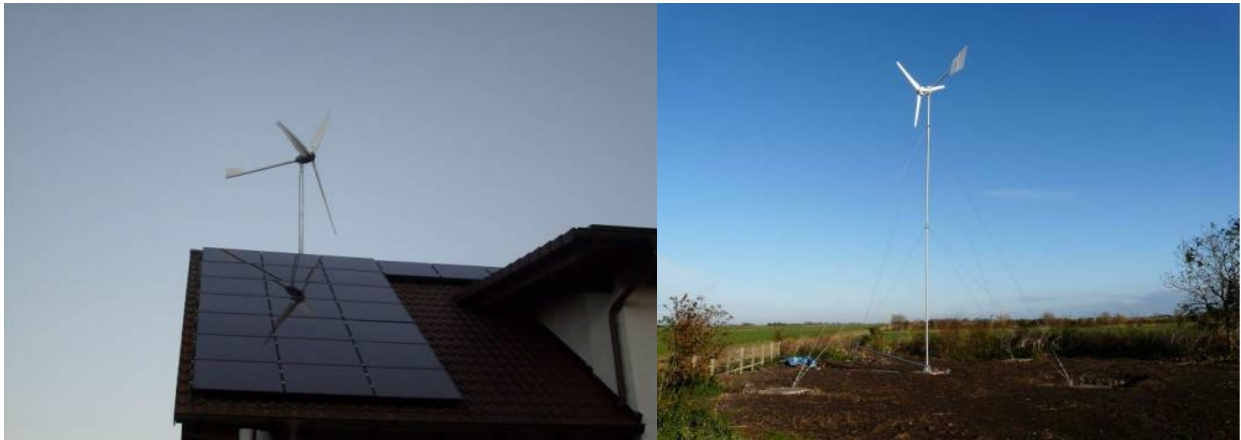
Slika 4.4. Mogući načini postavljanja malih vjetroagregata
