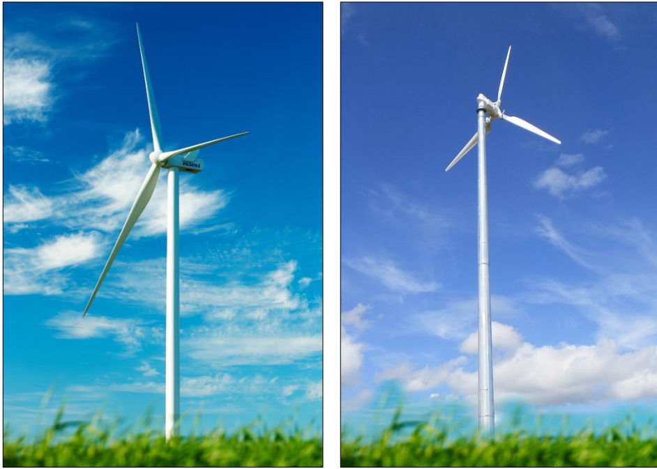
Slika 3.1.: Izvedba sa stupom iza lopatica i sa stupom ispred lopatica
