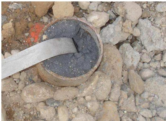
*Slika 7.1. Trakasti uzemljivač u cijevi punjenoj grafitnim prahom*
