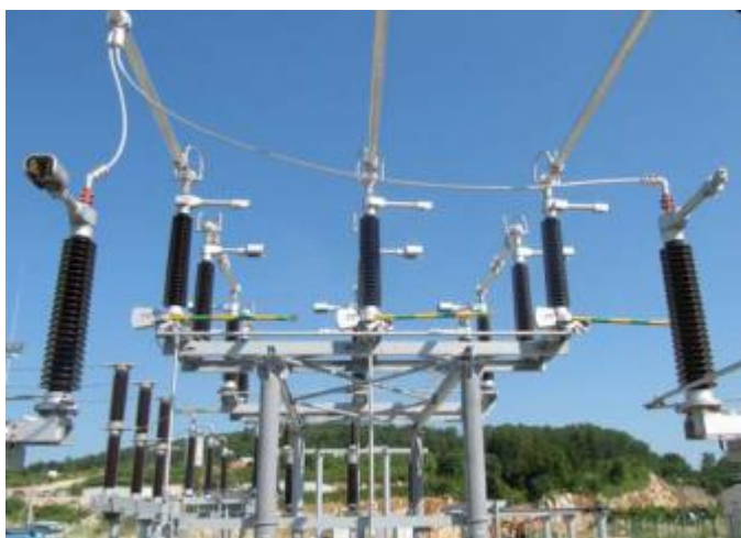
Slika 4.3. Okretni rastavljači za visoke napone
