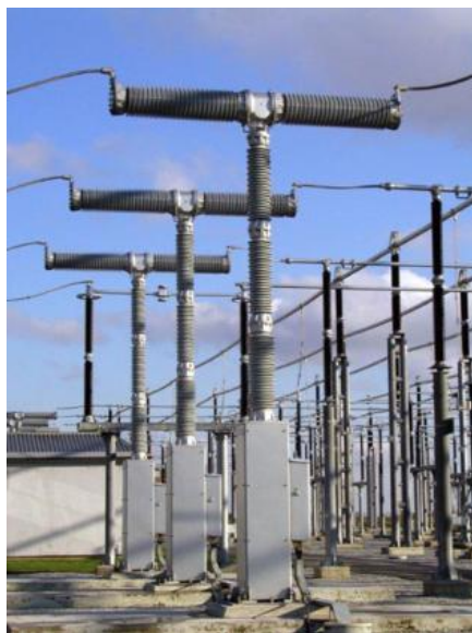
Slika 3.5. a) dvokomorni prekidač 400 kV; b) jednokomorni prekidač 245 kV
