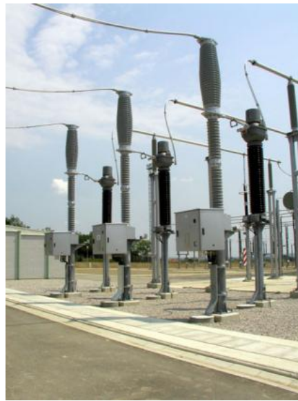
Slika 3.5. a) dvokomorni prekidač 400 kV; b) jednokomorni prekidač 245 kV
