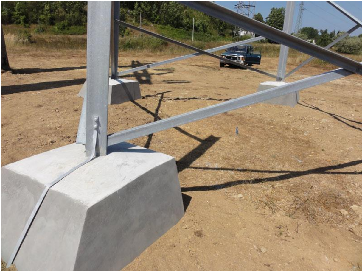
Slika 2.8. Uzemljenje dalekovodnog stupa
