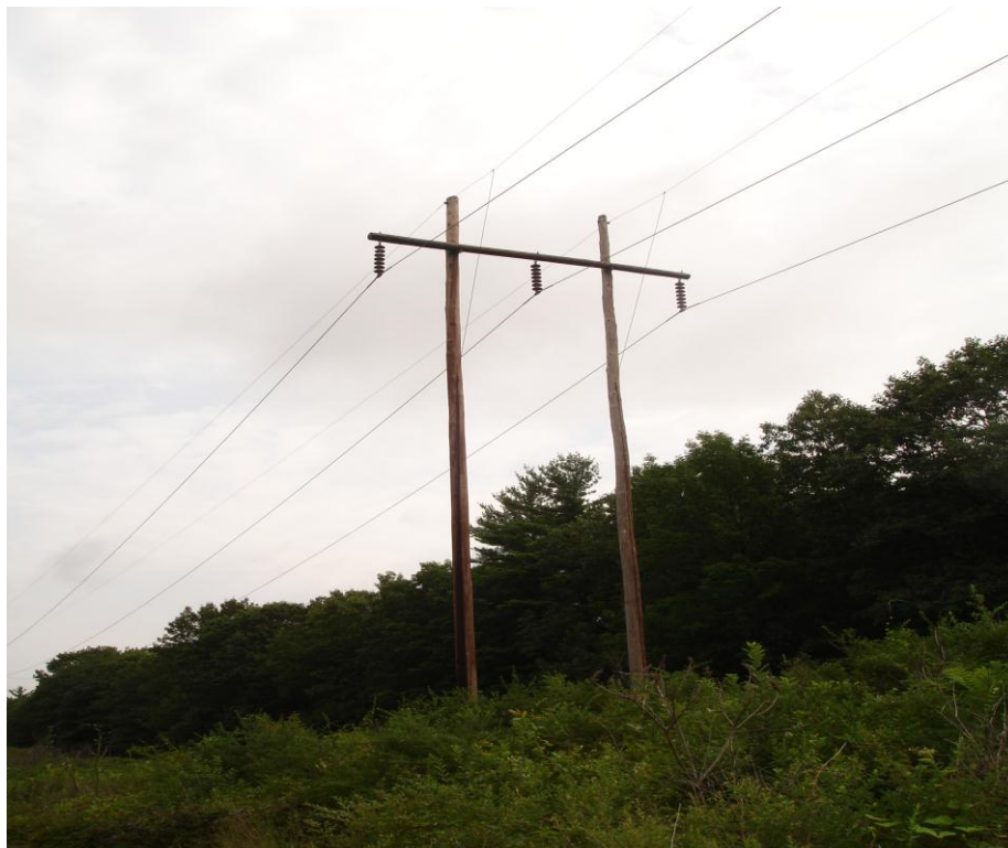
Slika 2.5. Drveni dalekovodni stup
