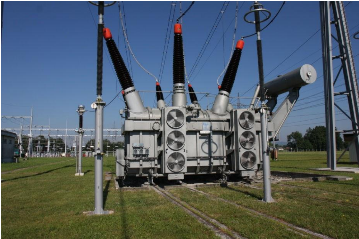
Slika 2.1.2. elektroenergetski transformator
