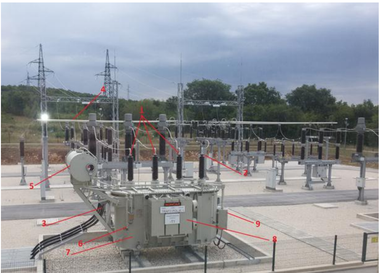
Slika 2.3: Dijelovi transformatora
