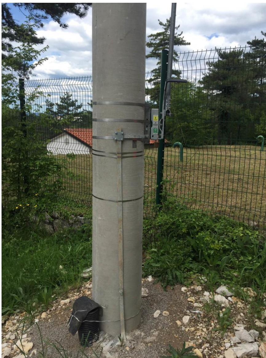
Slika 2.7. Prikaz mehaničke ručke ugrađene na stupu
