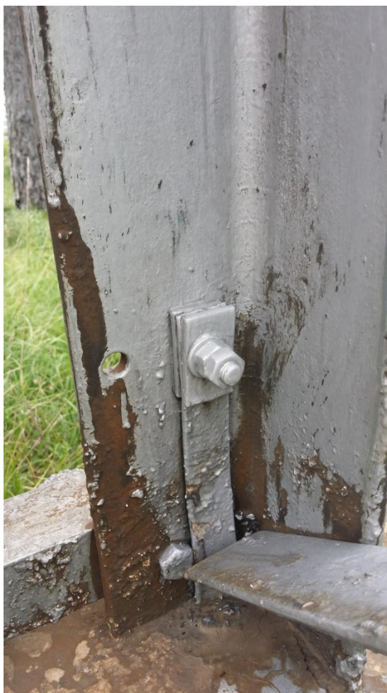
Slika 2.6. Prikaz trakastog uzemljenja na stupu
